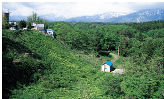
二本木工場の水力発電
