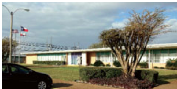
プラントエリアの外に配置された事務棟
