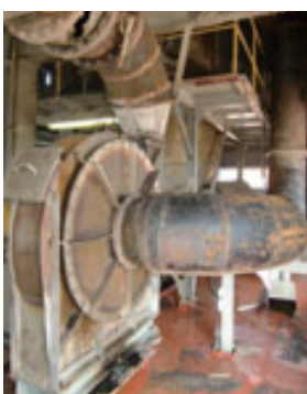
高岡工場トップジン火災事故 対策状況の一部
