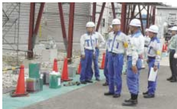
高橋社長による建設現場パトロール
