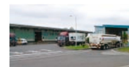
二本木工場 物流倉庫
