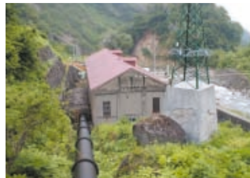
二本木工場 第三水力発電所
