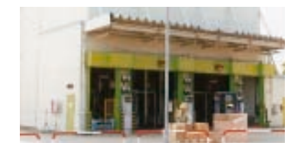
高岡工場 危険物立体自動倉庫
