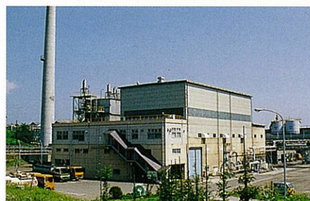
二本木工場 火力発電所
