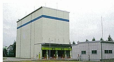
高岡工場 危険物立体自動倉庫
