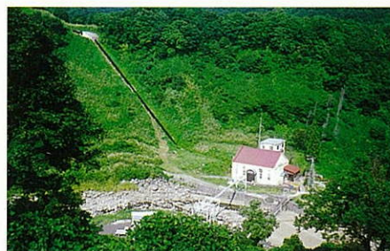
二本木工場 第二水力発電所
