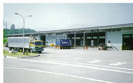
二本木工場 物流倉庫
