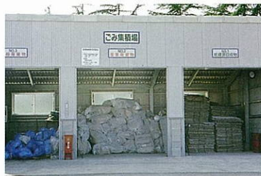
高岡工場 一般廃棄物分別回収場
